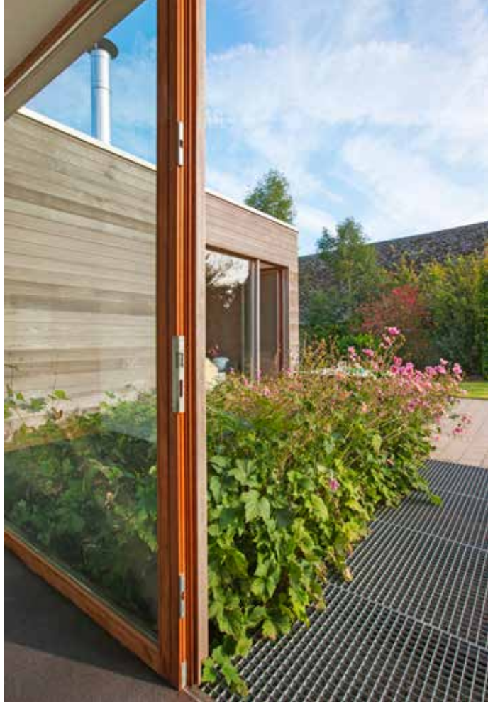
Une passerelle en caillbotis d'acier guide les visiteurs vers l'entrée de l'extension, dans le sas vitré.
